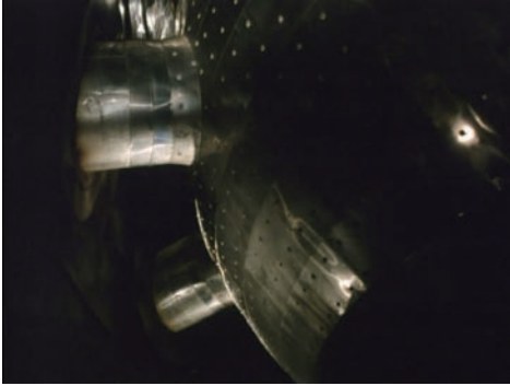
図-1 『東海発電所の建設記録』
